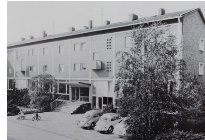
Bürogebäude der GWG Kölnstraße 24, Hürth-Hermülheim
