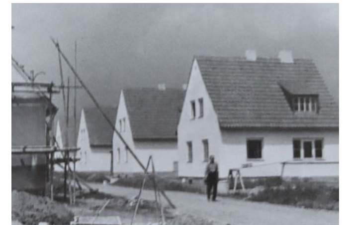
Bautätigkeit Kalscheurener Straße, Hürth
