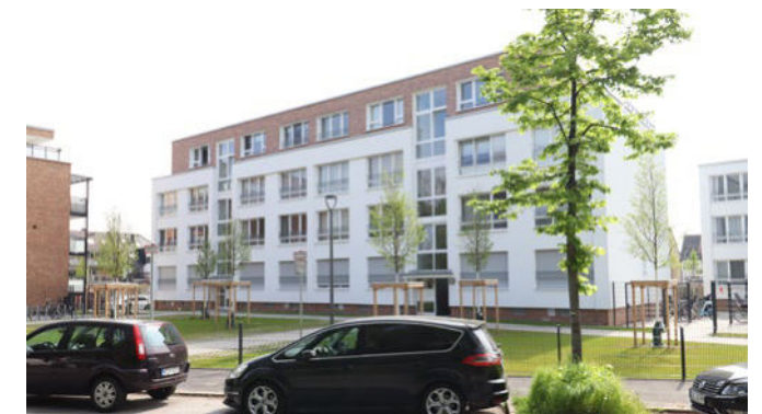
Modernisierungsmaßnahme Krankenhausstraße, Hürth-Efferen (vorher / nachher)
