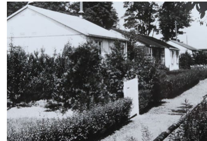
Stahlhäuser Kamillenweg, Junkersdorf
